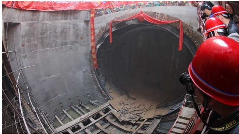
南水北调穿黄工程过河段
